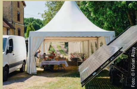
Der Solargenerator lädt Akkus und liefert Strom für die Basis
