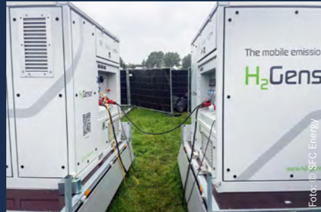
Wasserstromverstromung in Wacken via H 2 Genset
